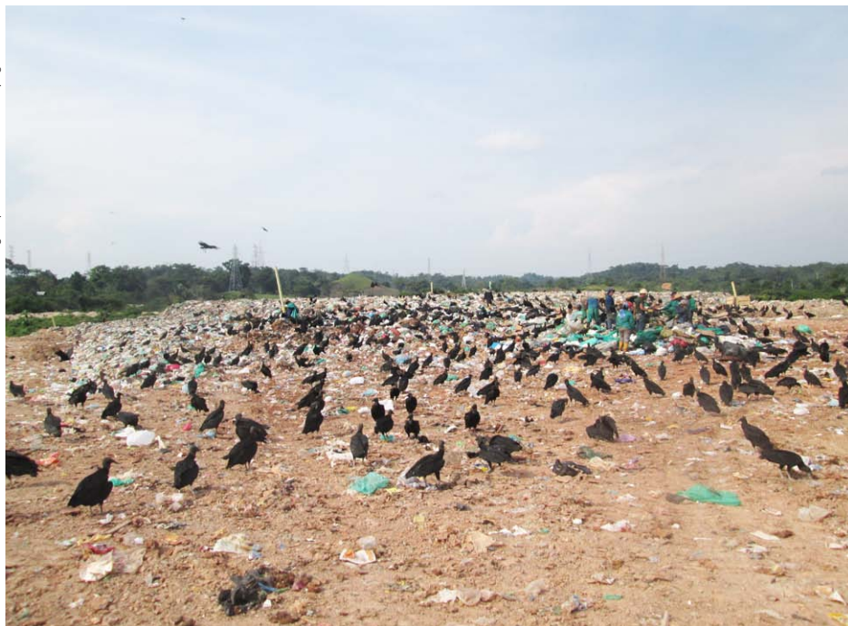
▶ Relleno sanitario La Esmeralda, municipio de Barrancabermeja, departamento de Santander. En la foto se observa una inadecuada disposición de residuos, a cielo abierto, sin material de cobertura y con la presencia de gallinazos y recicladores, los cuales se disputan los residuos tan pronto son dispuestos por los vehículos compactadores. Claudia Juliana Martínez Gómez, asesora Procuraduría Delegada para Asuntos Ambientales y Agrarios.
